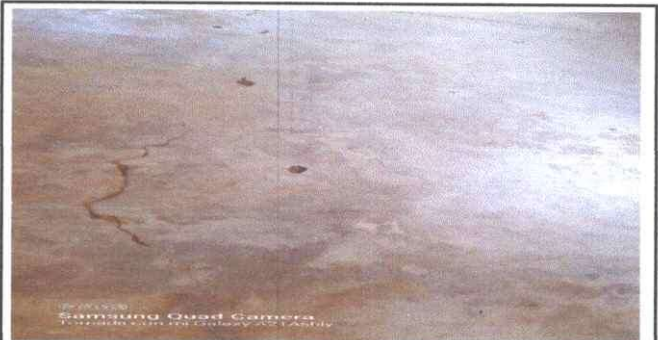
Foto 6: El piso se encuentra en las malas condiciones, se sustituirá por pisos cerámico.
