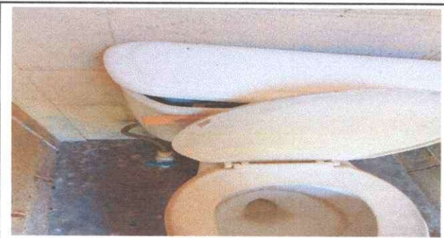
Foto 5: Los servicios sanitarios se encuentran en mal estado, se necesita el cambio de los accesorios.
